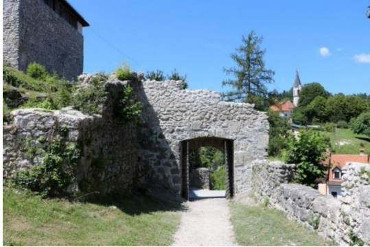
Železna vrata v obrambnem zidu
